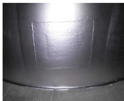
配管外側（補修後）
