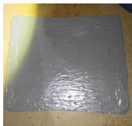
配管内側（補修後）
