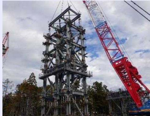
<鉄骨ユニット接合確認状況(2022年11月5日)>
