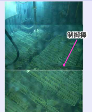
<3号機プール内の状況(2022.2.28時点)>
