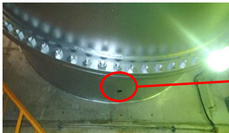
<循環水系配管欠損箇所>
