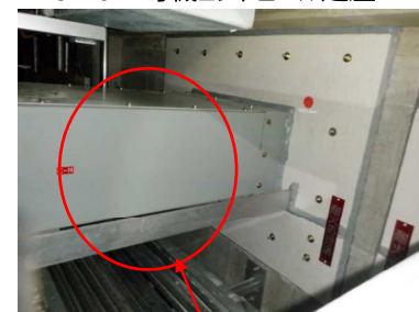
e. 6・7号機コントロール建屋
