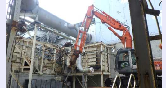
<ガレキ撤去作業の様子>
