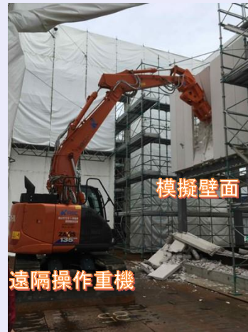
<燃料取扱機操作室撤去モックアップの様子>
