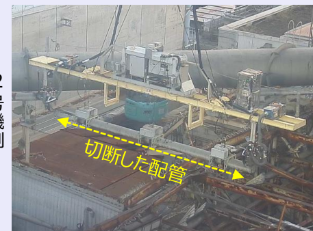
<配管切断作業の様子>
