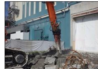
基礎解体状況
