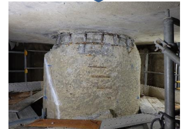
No.8杭 コンクリート はつり取り後
