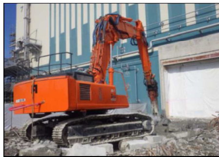
基礎解体状況
