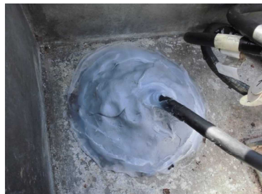
補修後のシール材
