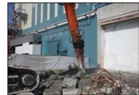
基礎解体状況
