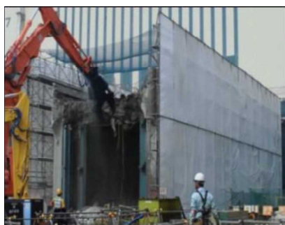
上物解体状況
