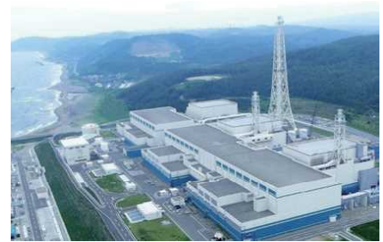
柏崎刈羽原子力発電所
