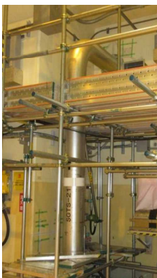
火災防護処理前
