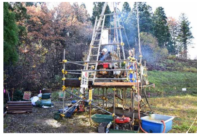
ボーリング調査
