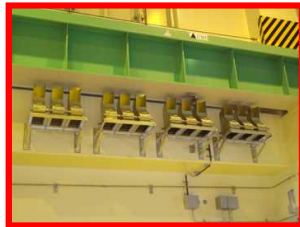
静的触媒式水素再結合装置 (PAR)
