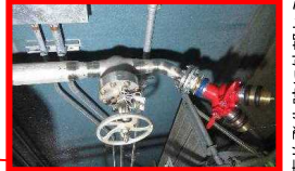
使用済燃料プールに注水するための外部接続口
