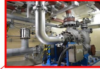
原子炉隔離時冷却系 (RCIC) のバックアップとして、原子炉への注水を行う
