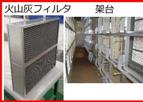
火山噴火による降灰時、非常用ディーゼル発電設備が火山灰で目詰まりしないよう、給気口にフィルタを設置する
