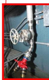
重大事故発生時に外部から使用済燃料プールに注水ができるよう、消防車を接続する
