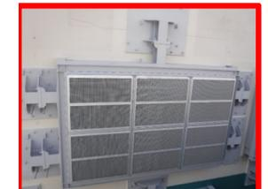
建屋の開口部に設置し、電巻により飛来した物の侵入を防止する
