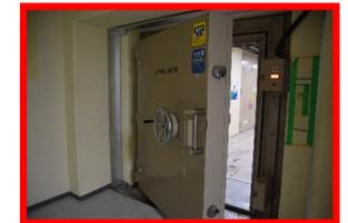
重要設備が設置されている部屋に、設備の破損で漏えいした水等の流入を防ぐ
