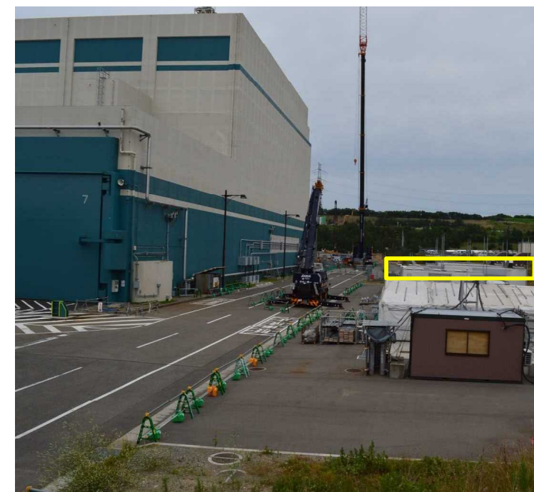
2020年6月 7号機タービン建屋南側の設置状況(2セットを配備)
