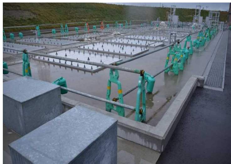
2019年12月 ガスタービン発電機の基礎状況
