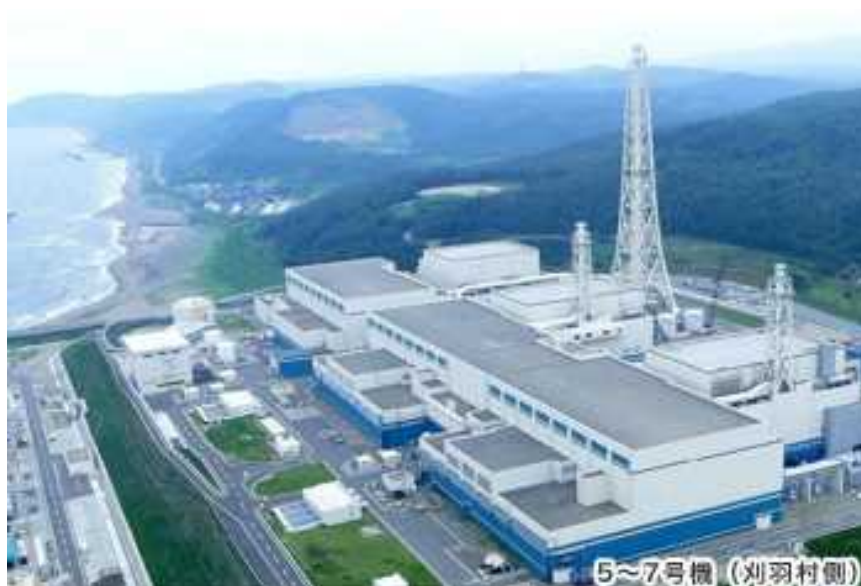
手前から 7 号機、6 号機、5 号機
