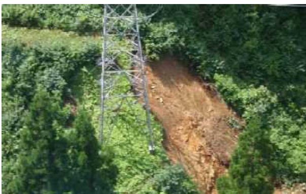
電気設備の周辺で発生した地すべり
