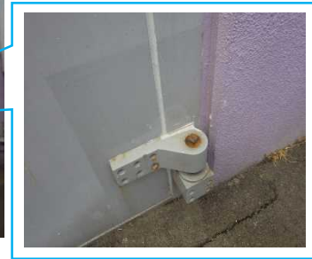
扉と枠の隙間をコーキング処理
