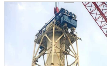
【写真①】筒身切断状況(10月27日)
