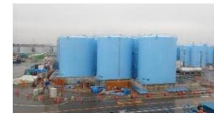
(溶接型タンク設置状況)
