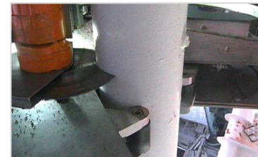
【写真③】斜材切断状況(11月7日)
