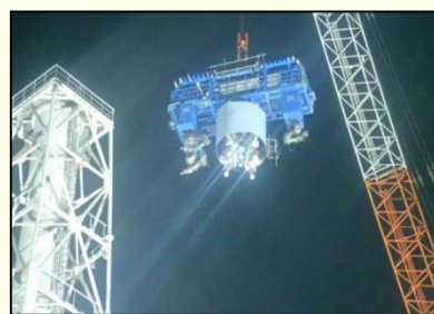
3ブロック目吊り下し状況
