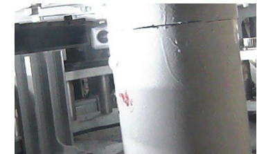
【写真④】主柱材切断状況(11月26日)
