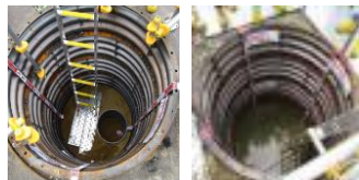
陸側遮水壁 内側 陸側遮水壁 外側
