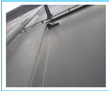
扉と枠の隙間をコーキング処理
