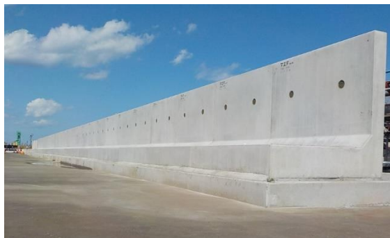
防潮堤設置状況
