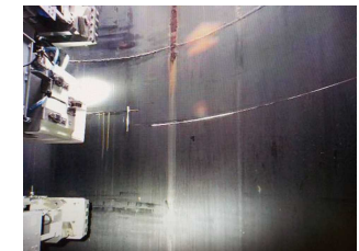
【写真②】切断作業状況・内側 (9月1日)
