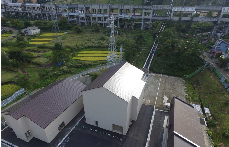
湯沢発電所外観
