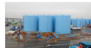
(溶接型タンク設置状況)
