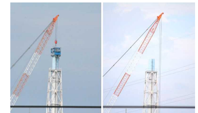
【写真④】解体前後の比較 (9月1日)
