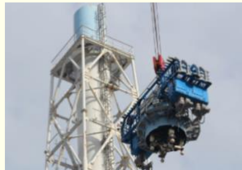
頂上ブロック吊り下ろし状況
