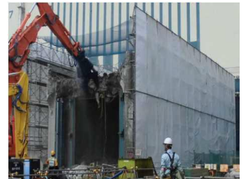
大物搬入口の解体
