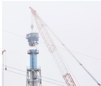
排気筒最頂部への設置確認作業
