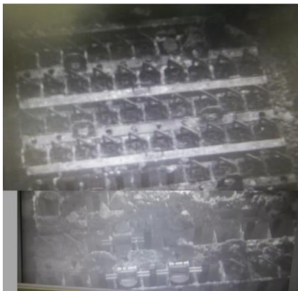
ガレキ撤去後の使用済燃料プール
