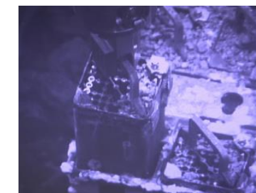
燃料取り出しの状況 (撮影日2019年4月15日)
