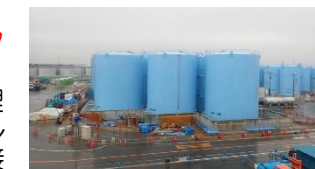
(溶接型タンク設置状況)
