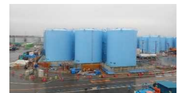
(溶接型タンク設置状況)
