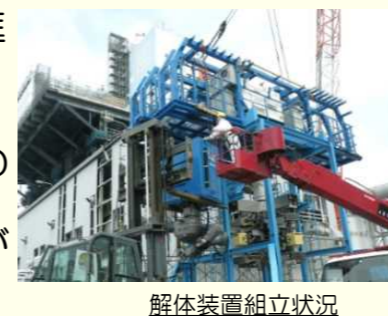
解体装置組立状況
