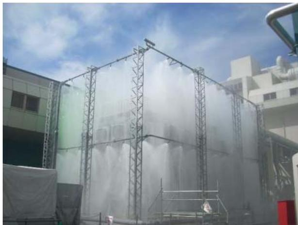
6号機 変圧器スプリンクラー試験
