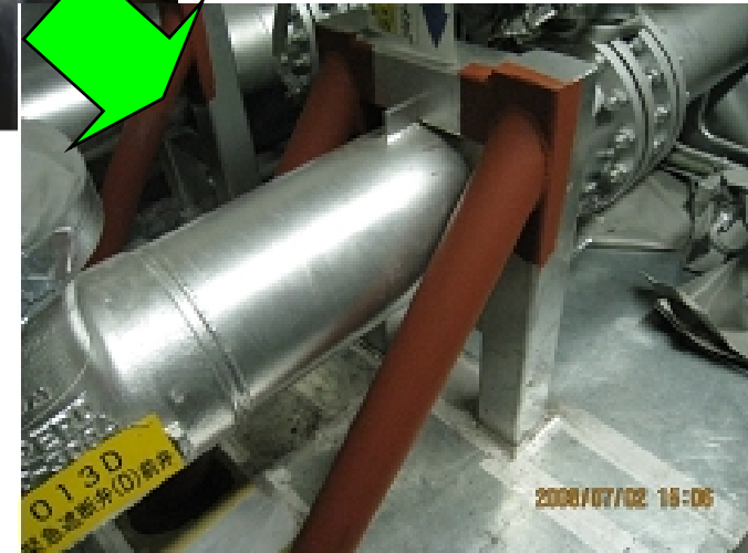
サポート強化により、強固な構造へ変更
