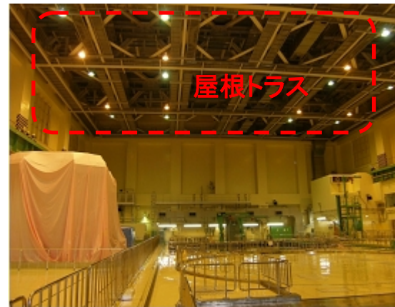
原子炉建屋 屋根トラス
