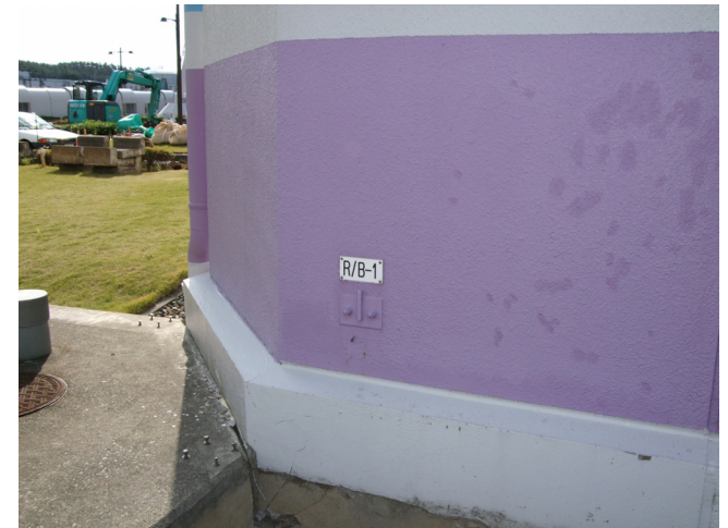
3号機原子炉建屋の測定点
