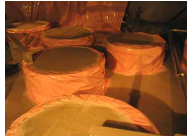
(ビニールシート養生)
