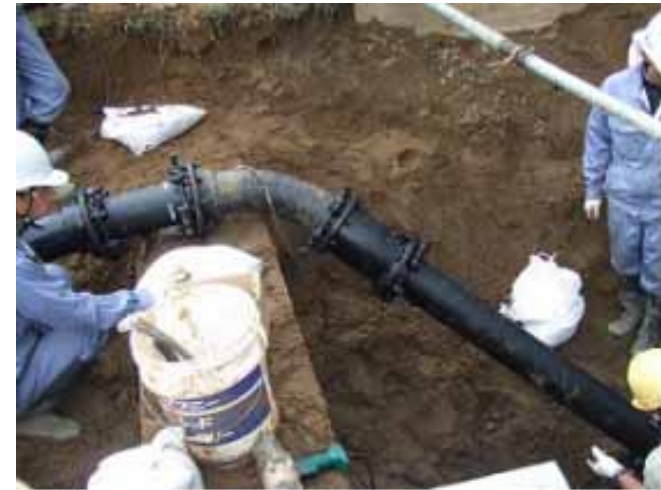
1号機 消火系配管破損
