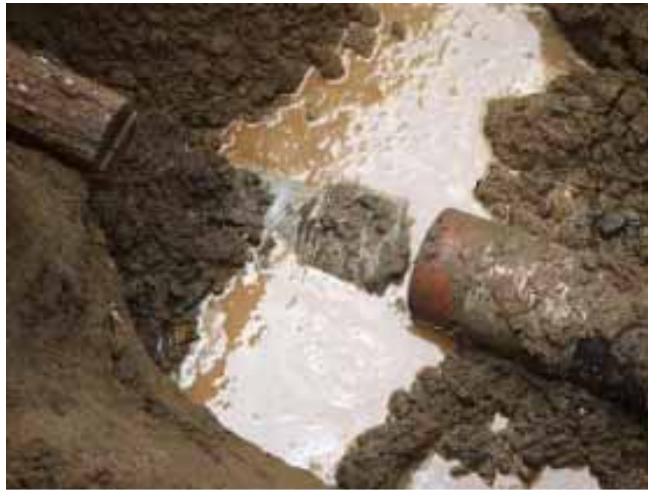
1号機 消火系配管破損
