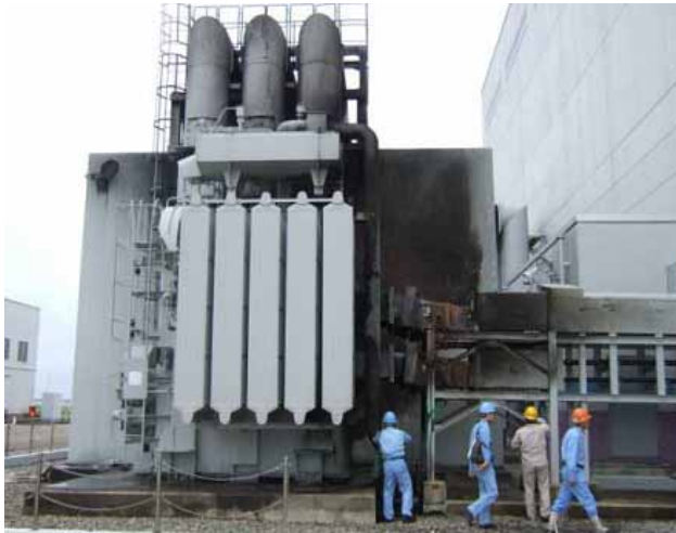
3号機 所内変圧器の搬出
