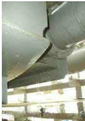
主変圧器下部油配管 ( 油漏れ )
