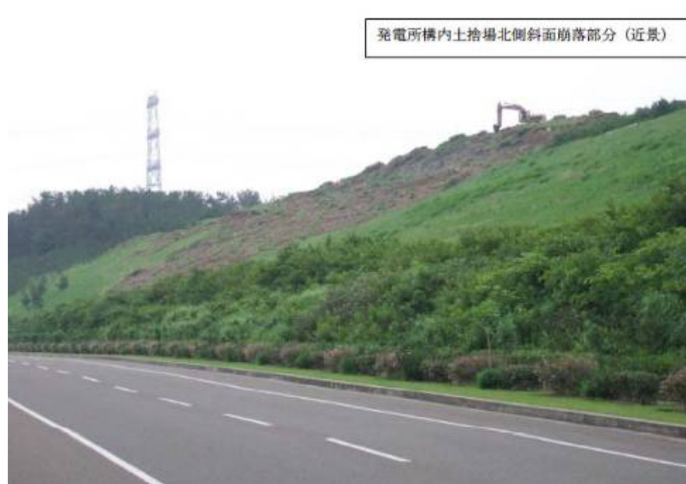
発電所構内土捨場北側斜面崩落部分 ( 全景 )
