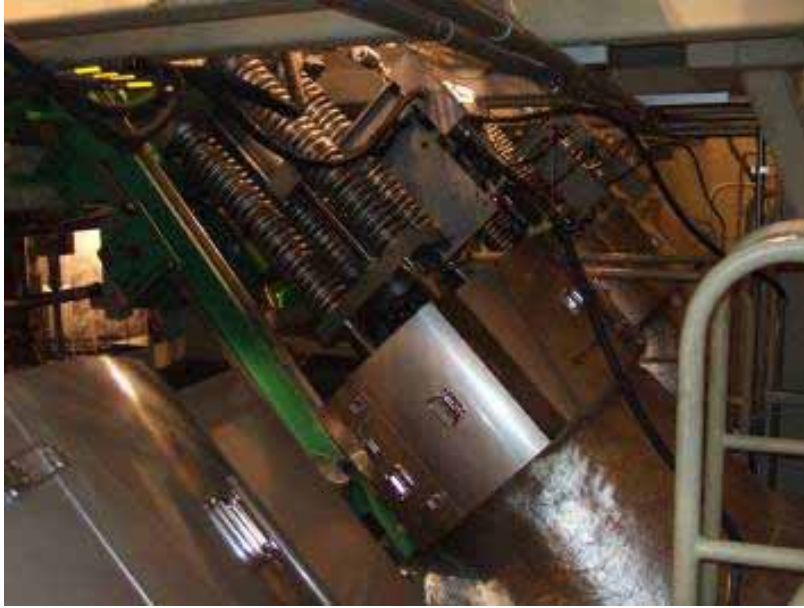
原子炉建屋地下2階 格納容器内 （主蒸気隔離弁）
