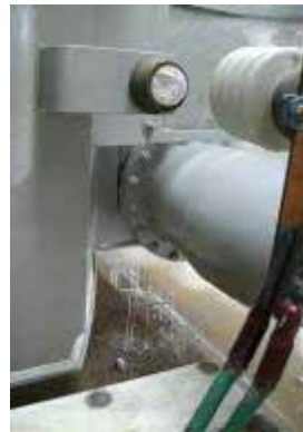
主変圧器下部油配管 ( 油漏れ )
