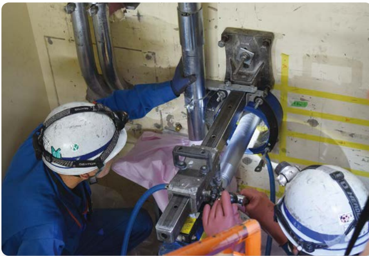
安全性向上のため、 新たな電線管を 通すための工事
