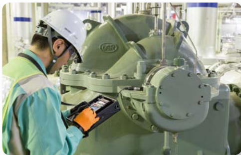
振動計を使い、運転中の回転機器に 異常な振動が無いかを調査
