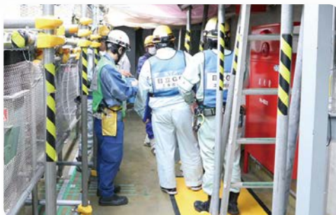
発電所の安全性を向上させる工事を行うにあたり、 現場の状況を確認する当社社員と協力企業の社員
