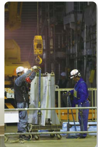
クレーンによる 機器の吊り上げ
