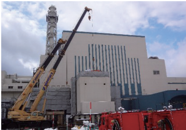
工事中のフィルタベント設備（6号機）
