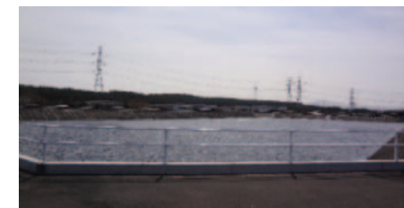
容量約2万トンの貯水池
