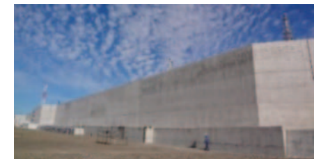
海拔高さ約15メートルの防潮堤
