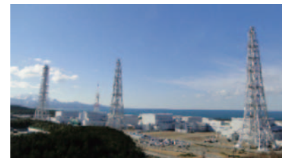
1~4号機の全景(展望台)
