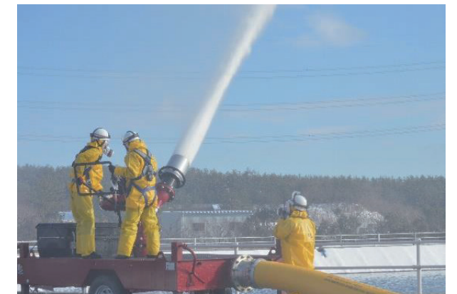
「大容量放水設備」は、原子炉建屋の損壊時などに建屋に放水し、放射性物質の拡散を可能な限り抑えます。
