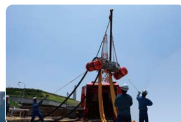
水中ポンプの吊上げの様子
