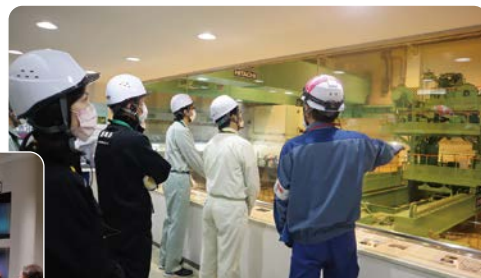
7号機原子炉の現場確認の様子
