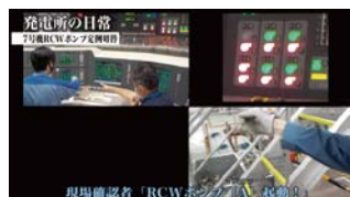
7号機RCWポンプ定例切替
