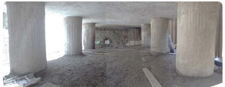
4号機大物搬入建屋杭全景
