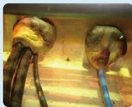
ケーブル漏えい箇所
