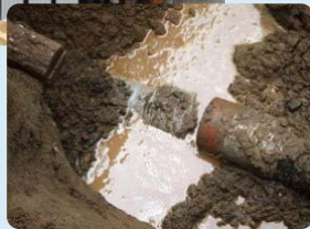
破断した 消火配管
