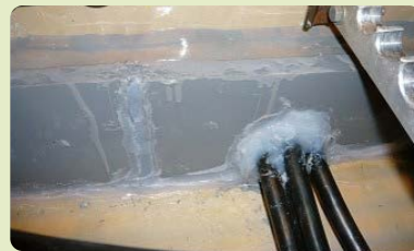
ケーブル漏えい 箇所(対策後)
