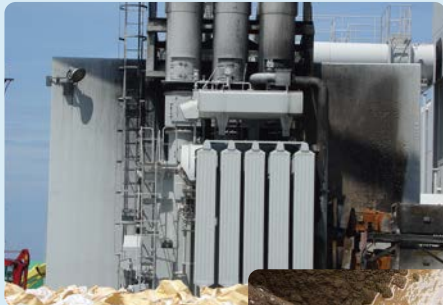
3号機所内変圧器(火災後)
