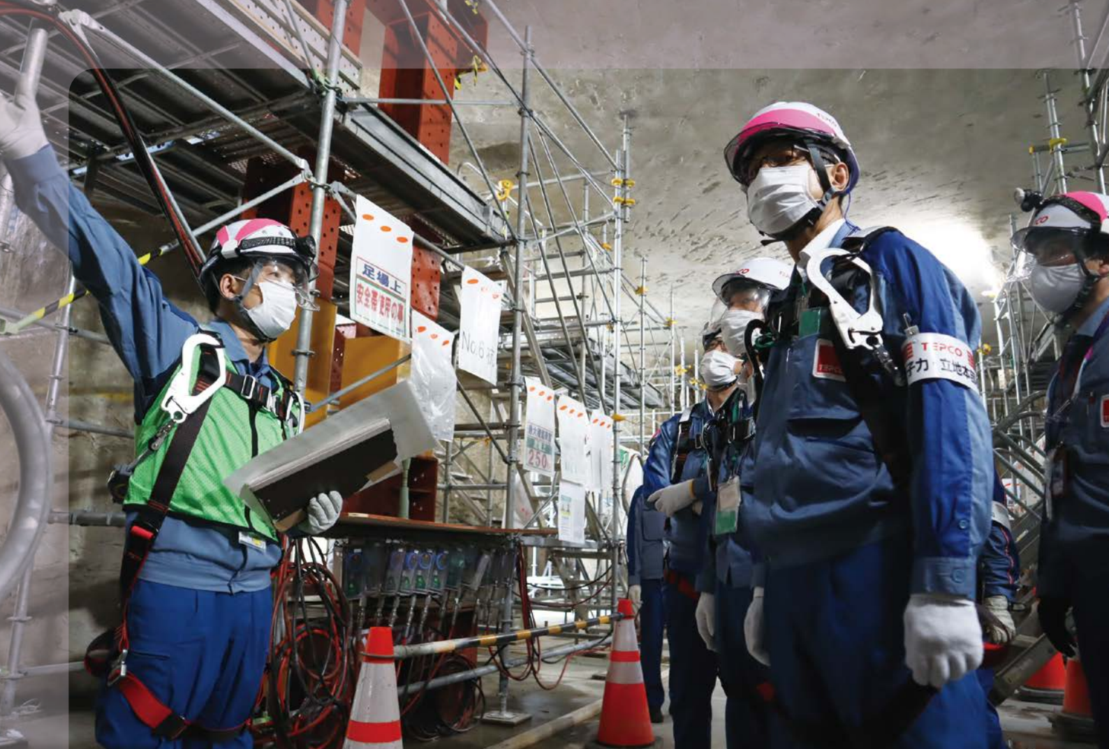
現場確認を行う福田
