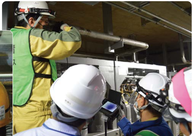
目視で確認できない場所はファイバースコープカメラを使用し確認
