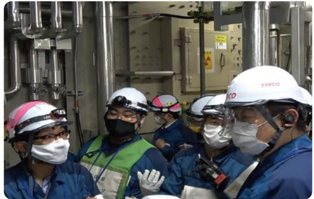
貫通部について社長と共に現場確認を行う宮田(左)
