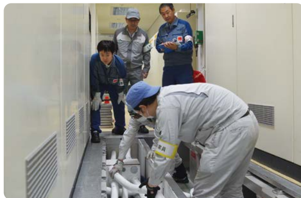
ケーブルの耐火性能を向上させる保護管
