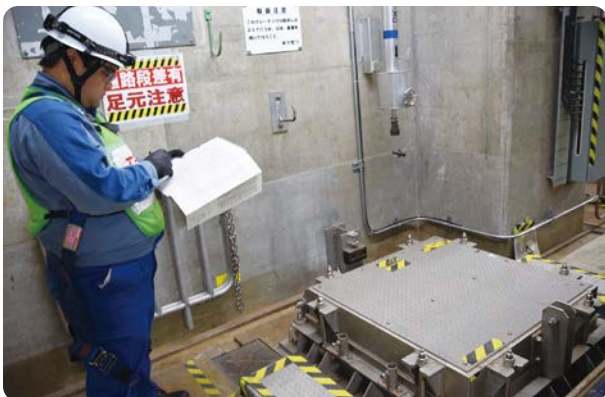
床下から水が溢れ出ないように取り付けた 閉止板の設置状況を確認
