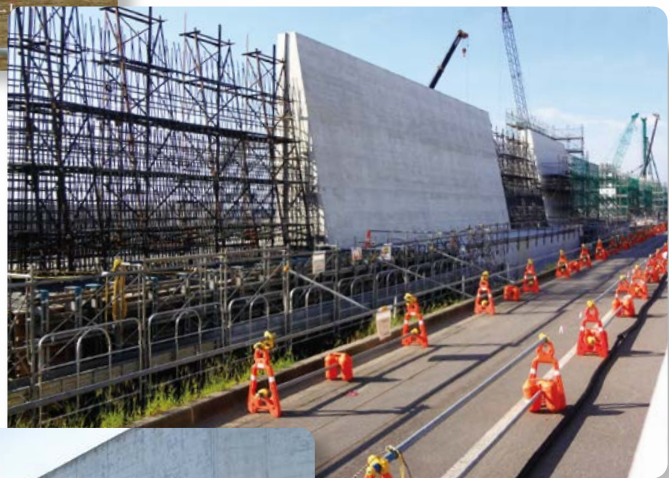
防潮堤の建設工事 (2012年8月撮影)
