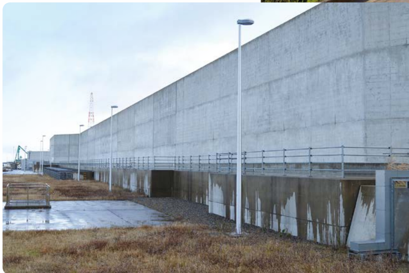
建設工事が完了した防潮堤 (2017年1月撮影)
