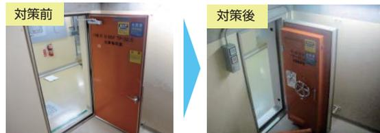
原子炉を冷やす設備が設置されている重要エリアの浸水を防ぐため、エリア入口扉の水密性を高めています。
