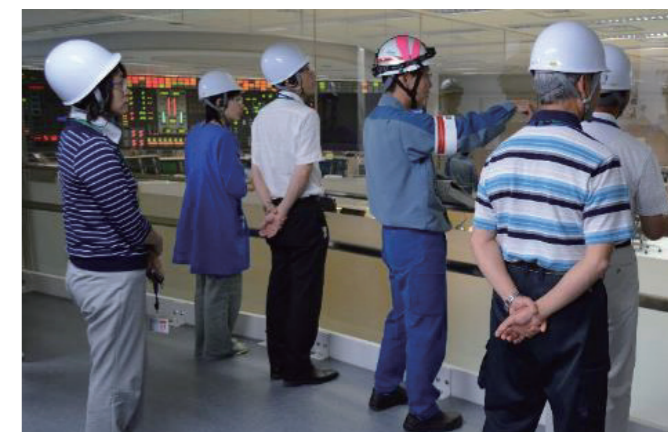
6/7号機中央制御室
