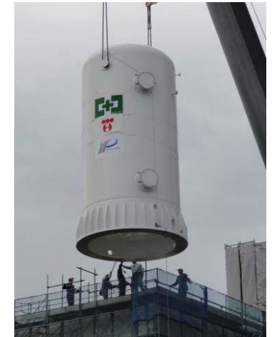
フィルタベント本体吊り込み作業
