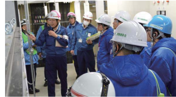
免震重要棟空調設備
