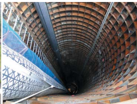
深さ約30mの断層調査用立坑
