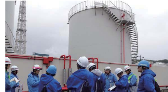
屋外軽油タンク
