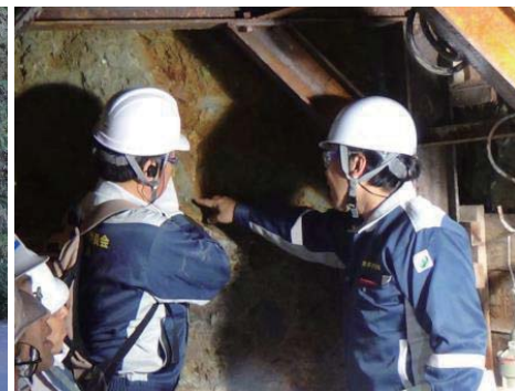
立坑内の確認
