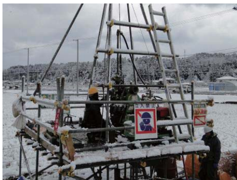
ボーリング調査
