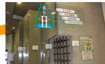
原子炉を囲む壁（実物大）
