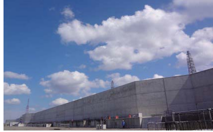
1～4号機側防潮堤
