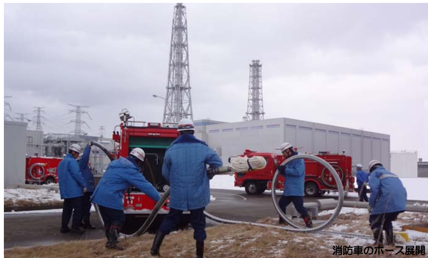
消防車からホースを連結し 建屋の注水口へ向かいます
