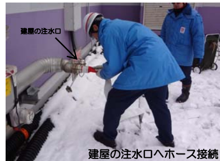
建屋の注水口へホース接続
