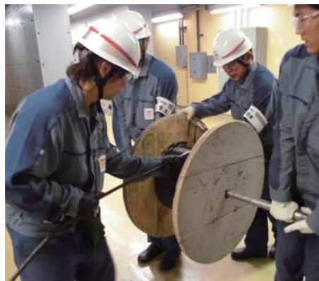
電源ケーブルの敷設訓練
