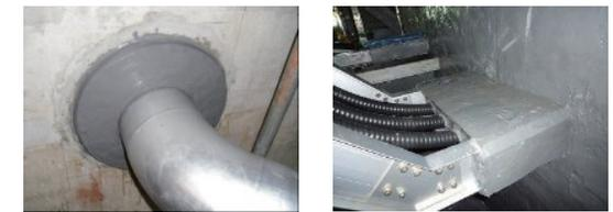
配管、ケーブル貫通部の止水処理施工例
